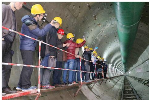
中铁国际班到南昌地铁2号线6标、3号线7标项目工地观摩学习
